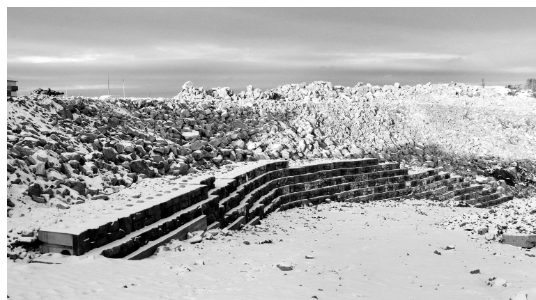
Так выглядит подпорная стена со стороны ул.Пикуля. Еще одна такая же будет находиться со стороны будущего стадиона школы.
