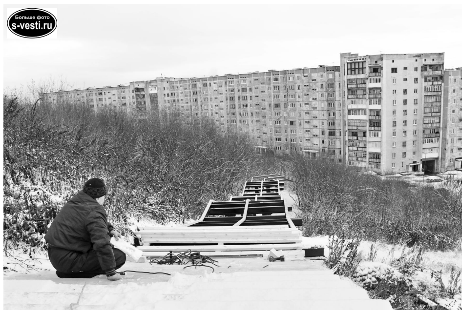
Для настила трапа будет использовано около 22 м 3 струганой древесины.
