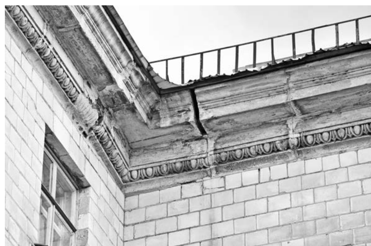
Декор карнизов на ул.Комсомольской, 11, в ходе капремонта будет сохранен, швы между плитами восстановлены.
