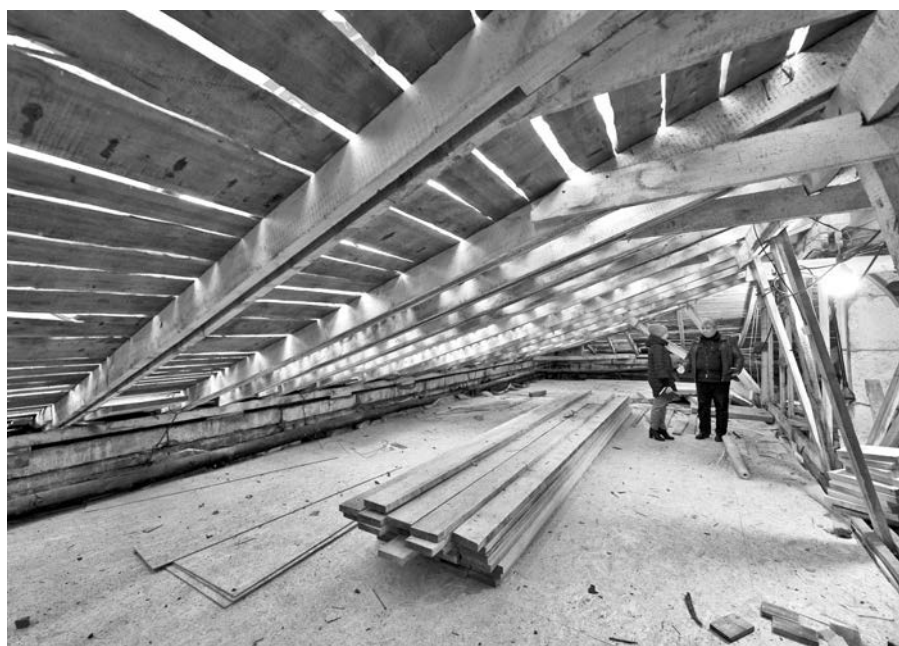
Чердачное помещение дома №2 по ул.Кирова по завершению работ будет расчищено от мусора.
