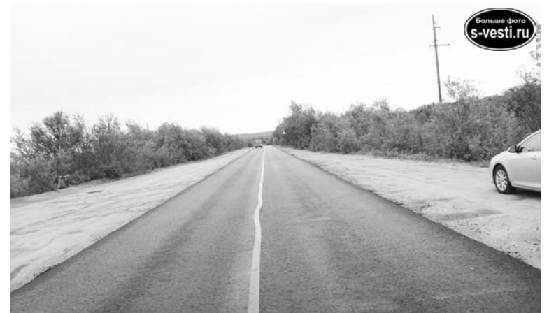
Отремонтированный участок дороги на Североморск-3.
