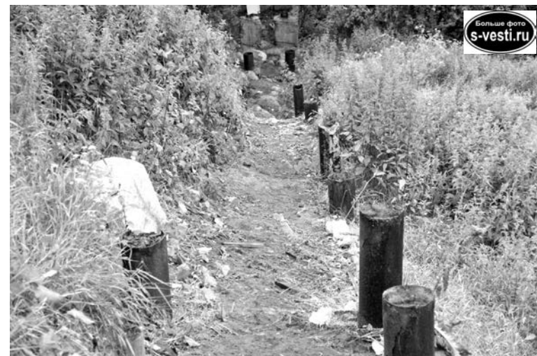
Трап на ул.Сизова разобрали подчистую.
