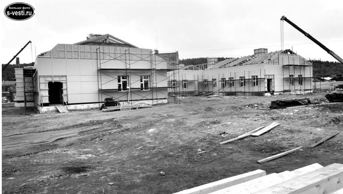
Строительством детского сада в Авиагородке занимается ООО «Мурманстрой». Проектная стоимость объекта – 120 млн рублей.
