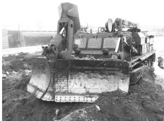
Многофункциональный гусеничный бульдозер БАТ при подготовке подрывных работ - техника незаменимая.
