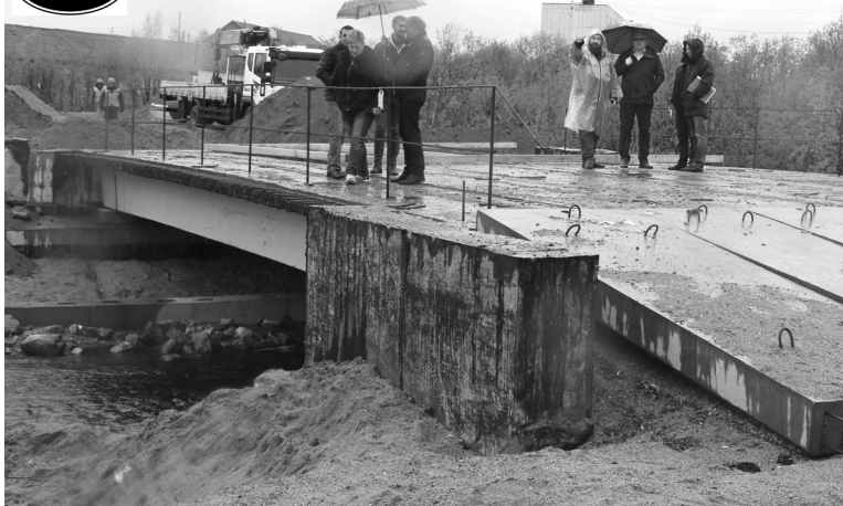
Ширина проезжих частей нового моста составит по 3,5 м каждая. Еще 1,5 м уйдет на пешеходные зоны.
