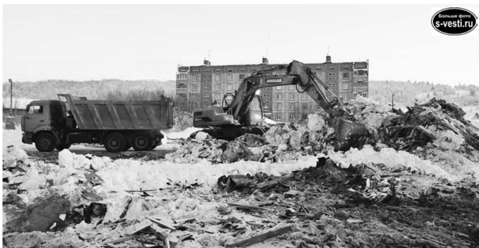
На стройплощадке на данный момент трудятся 12 человек и 6 единиц техники.
