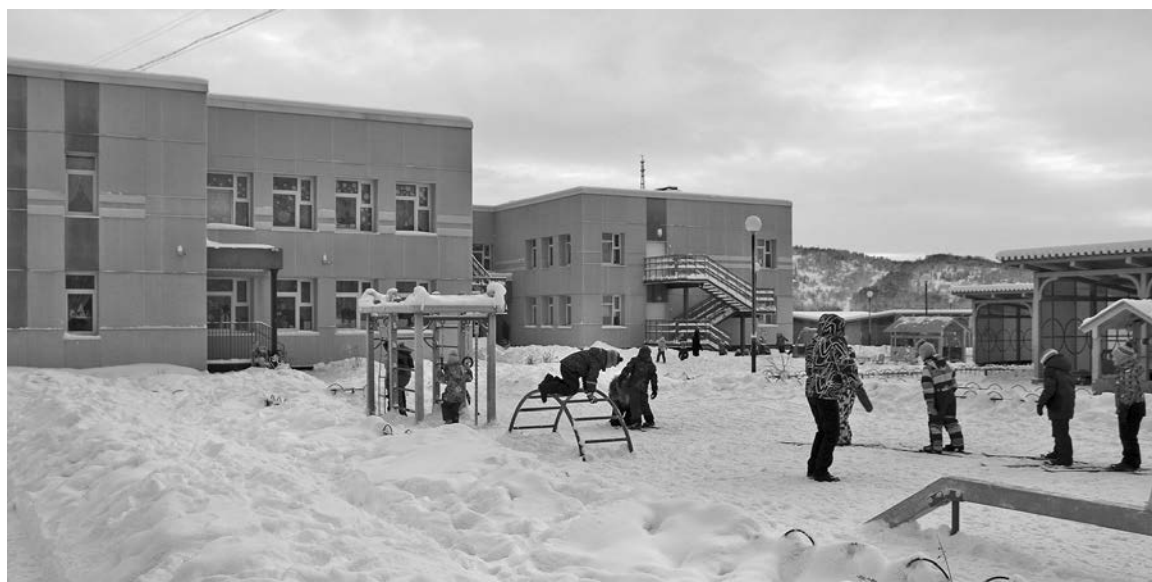
Детский сад №15 «Акварелька» после незапланированного ремонта стал комфортнее.
