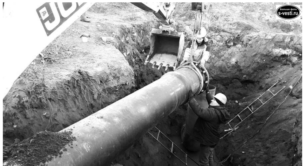
Последнее соединение - и водовод готов к работе.
