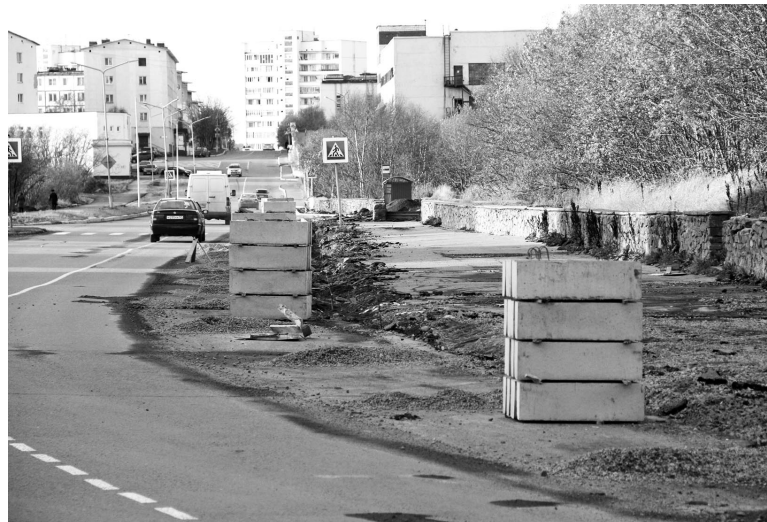
Плановая замена бордюрного камня на ул.Сгибнева.
