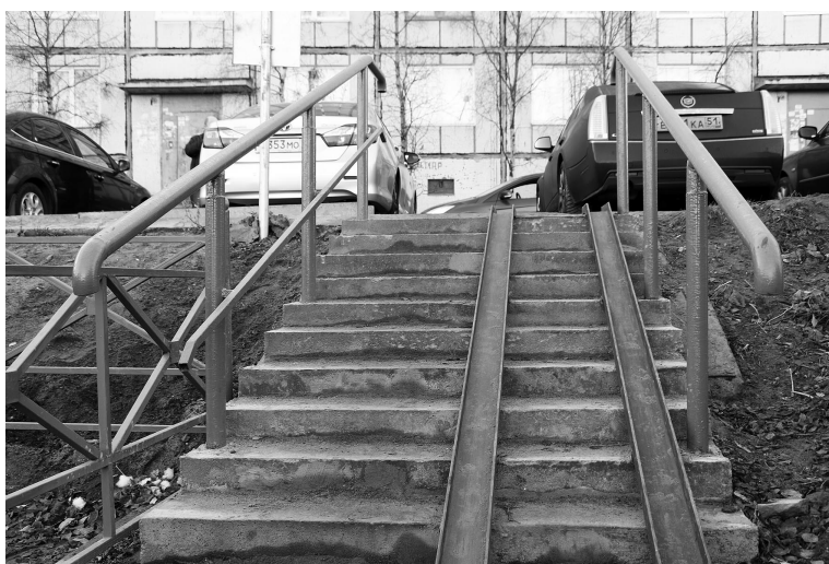
Лестница к детской площадке в п.Сафоново выглядит вполне надежно.
