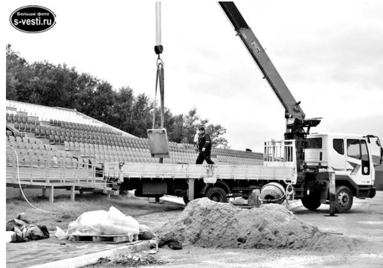
Трибуна на Приморской площади ремонтируется в рамках программы как общественная территория.
