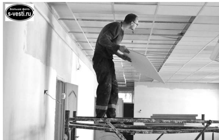
Ремонт в СШ №12 подразумевает монтаж подвесных потолков, замену системы освещения и дверей на входе в коридоры, покраску стен, новые радиаторы отопления.
