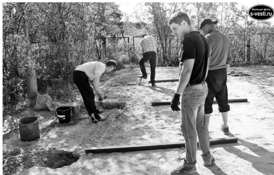
Продолжается установка ограждения на пришкольной спортплощадке в п.Щукозеро.
