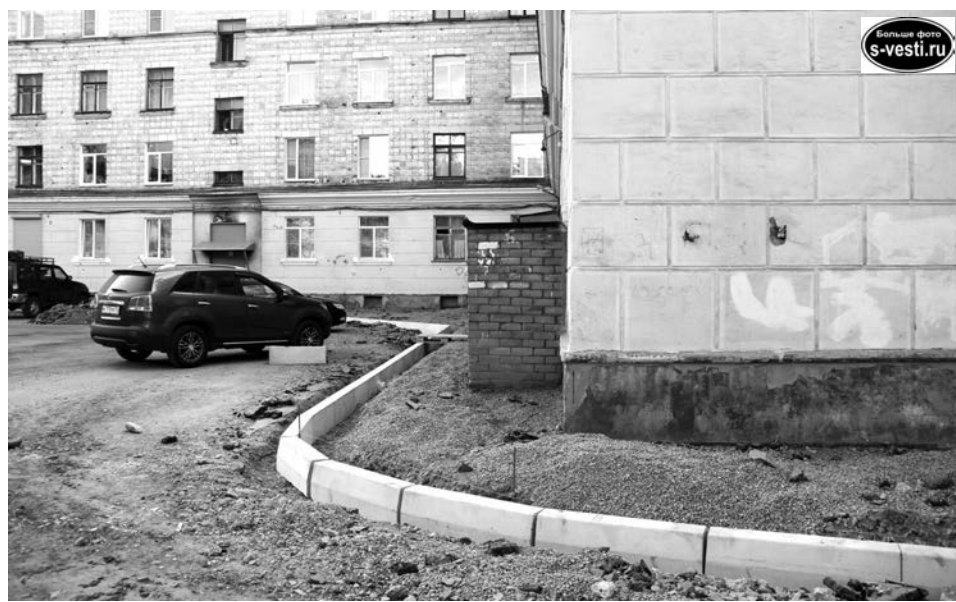
В доме №10 по ул. Душенова уже проведена часть работ.
