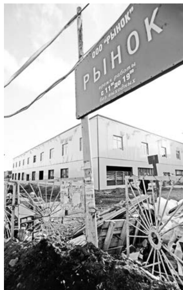
Строительный мусор - рабочий момент любого соиздания.
