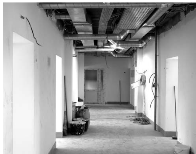
Следующий этап капитального ремонта - внешняя отделка помещений.
