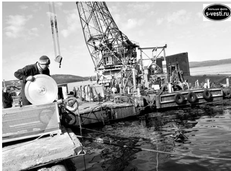
Идет распил алмазным тросиком прибрежного «утопленника».
