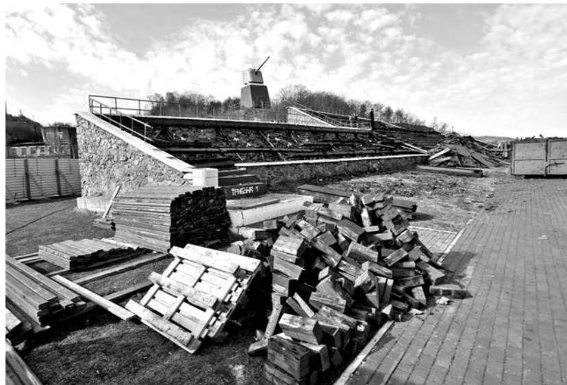
Вовремя начата реконструкция трибун: старые материалы уже подверглись коррозии.
