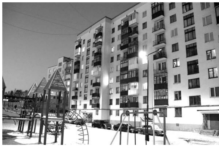
Во дворе ул.Морской, 10, установили дополнительное освещение.
