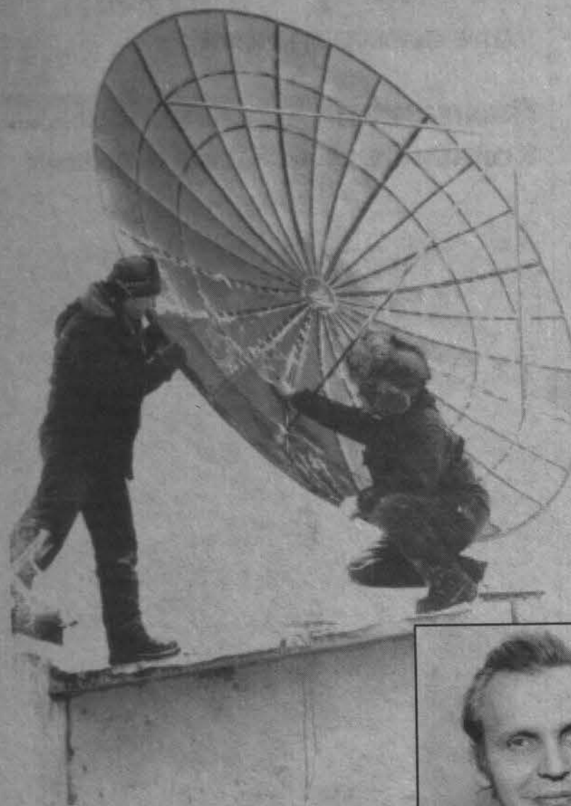
Монтаж телевизионной приемной системы.
