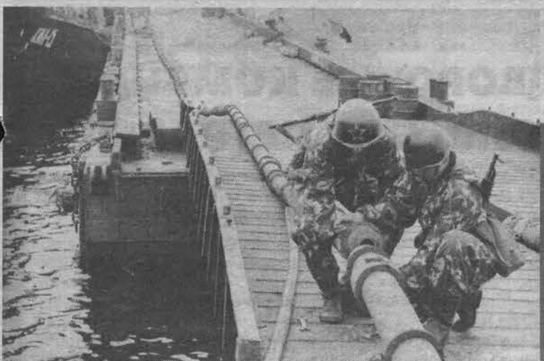
Сборка полевого водопровода для обеспечения водой надводного корабля.
