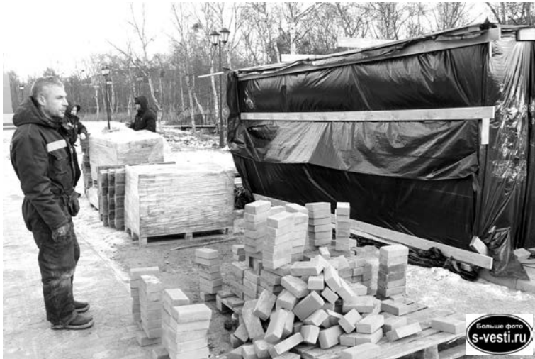
Жизнь внесла свои коррективы - и процесс укладки плитки в городском парке значительно усложнился.
