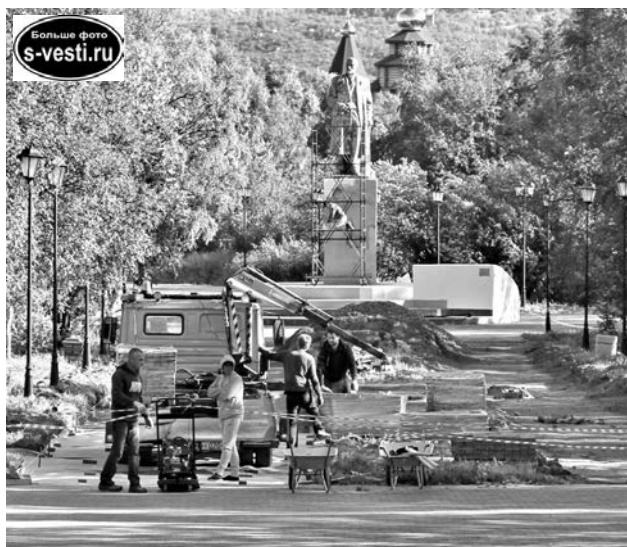
Работы по укладке плитки в городском парке.
