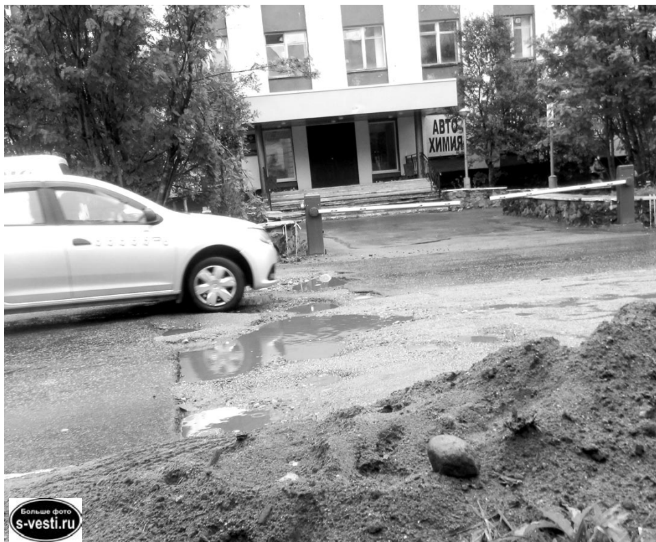
Не светофор, но приходится притормаживать. Так выглядит участок дороги по ул.Падорина в период дождей.
