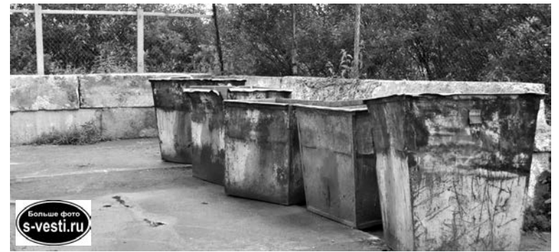
Контейнерная площадка между домами №17 и №14 по ул.Елькина приведена в порядок.
