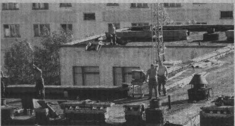
А рабочие уже приступили к ремонту кровли детского сада №16.
