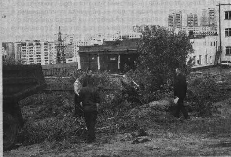
Авиагородок. Здесь прошлым летом начали строительство автостоянки, а мешающие новому проекту деревца извели под корень.
