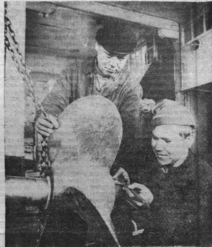
запрессовку опорных винтовых втулок гребного вала. Каждодневной работой подтверждает он квалификацию слесаря-судоремонтника четвертого разряда.
